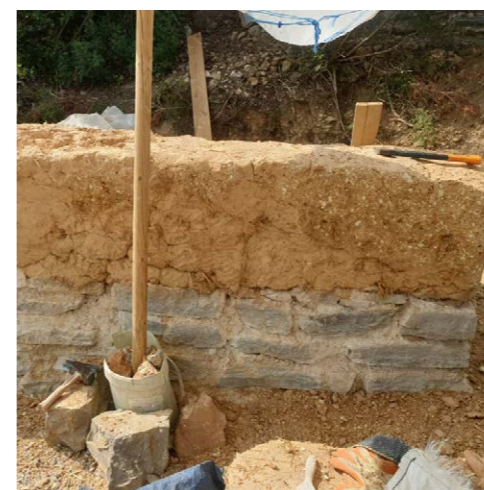
Première levée de bauge
