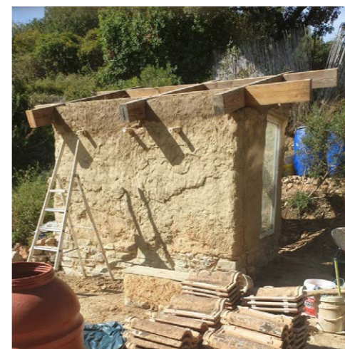
Pose de la charpente
