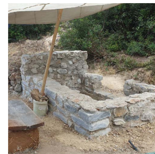
Remontée des fondations pour protéger les murs en terre
