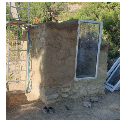
Troisième levée de bauge et installation des menuiseries
